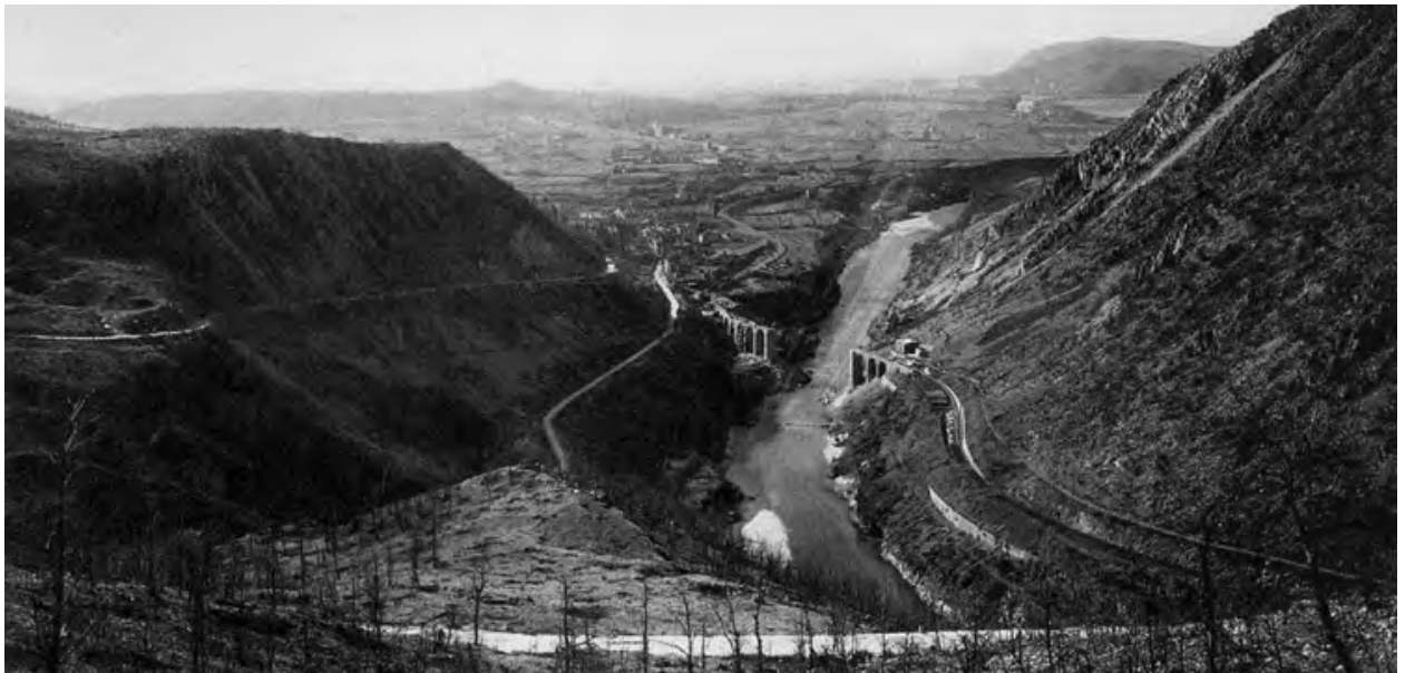
Ponte ferroviario distrutto sull'Isonzo a sinistra il monte Santo e a destra il monte Sabotino.
