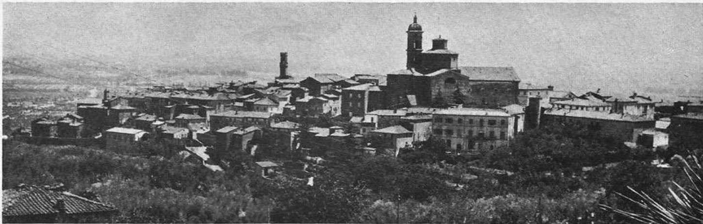
▲ 133 - Profilo dell'abitato con la torre del Palazzo Comunale e la Collegiata di San Martino.
