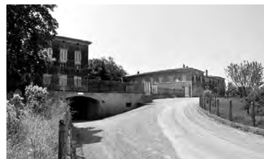
Sopra, il Palazzo di fattoria dell'Abbadia.
